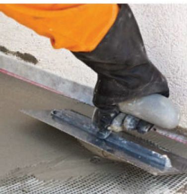
Applicazione di Monogum con spatola metallica liscia
