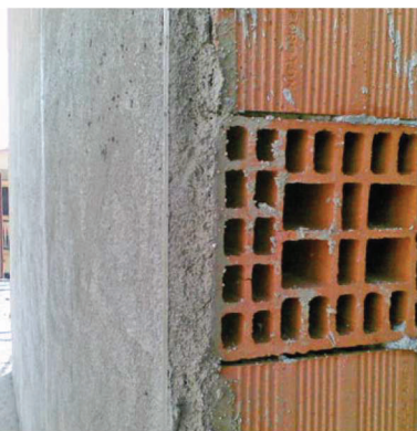
Esempio di applicazione dell'intonaco isolante Thermoisol
