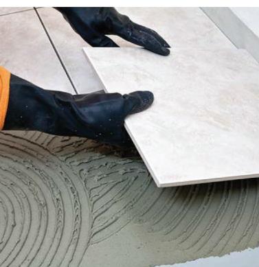
Posa delle piastrelle
