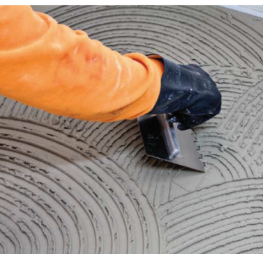
Applicazione di Flex Top 100 C2TES1 con spatola metallica
