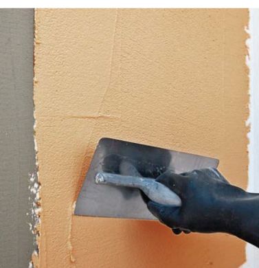
Applicazione di Taormina Silox con spatola metallica
