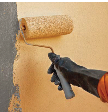
Applicazione a rullo o pennello di una passata di fissativo Primar Silox per rivestimenti ai silossani
