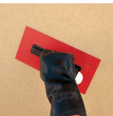
Finitura della superficie con fratazzo in plastica
