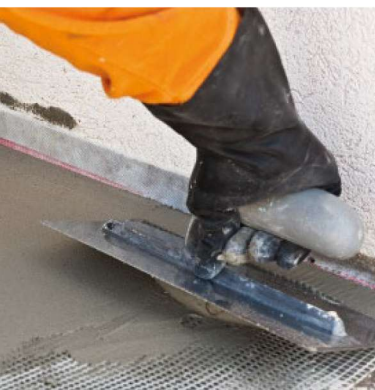
Applicazione di Monogum con spatola metallica liscia
