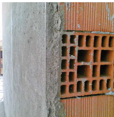
Esempio di applicazione dell'intonaco isolante Thermoisol
