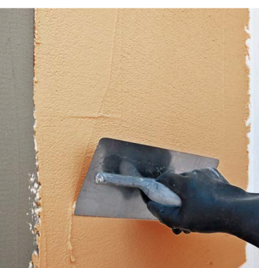
Applicazione di Taormina Silox con spatola metallica
