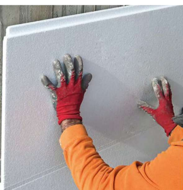
Posa del pannello termoisolante
