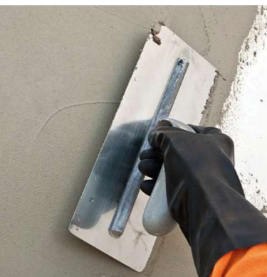
Applicazione di Rasocem KR EXTRA con spatola metallica liscia.
