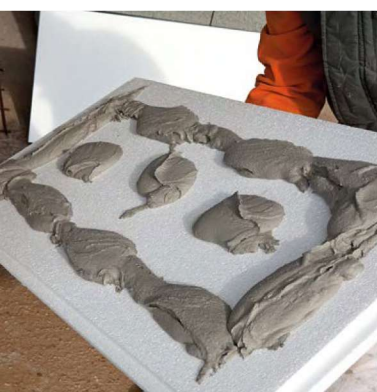
Applicazione a punti di Rasocem KR EXTRA sul retro del pannello termoisolante
