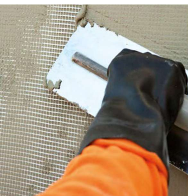
Annegamento della rete in fibra di vetro e applicazione della seconda mano di Rasocem KR EXTRA.
