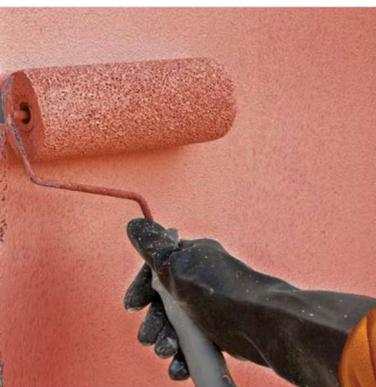
Applicazione a rullo / pennello di una mano di fissativo Primar Silox per rivestimenti ai silossani
