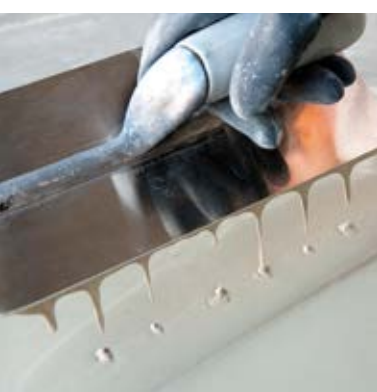
Stesura con spatola metallica
