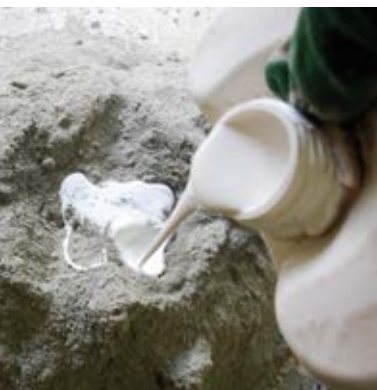
Aggiunta di Top Latex alla malta
