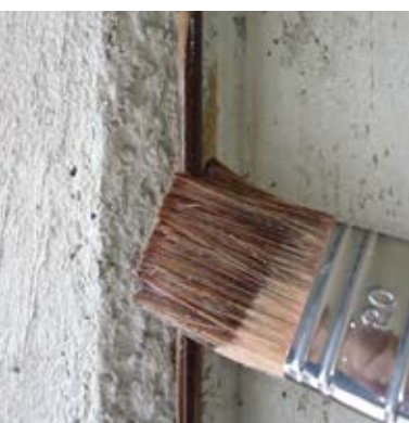
Applicazione a pennello di TOP FER
