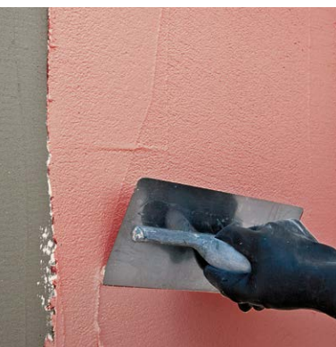
Applicazione di Tonacolor Sil con spatola metallica
