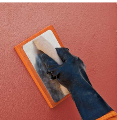
Metodo 2: Finitura della superficie con filtro di spugna
