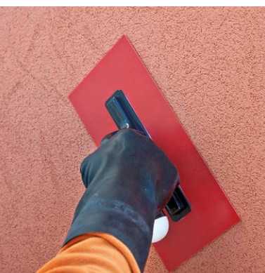
metodo 1: finitura della superficie con fratazzo in plastica
