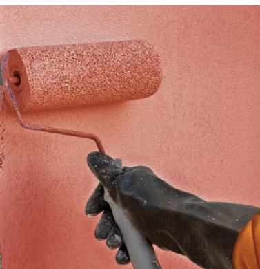
Applicazione a rullo o pennello di una passata di fissativo Primar Sil per rivestimenti ai silicati
