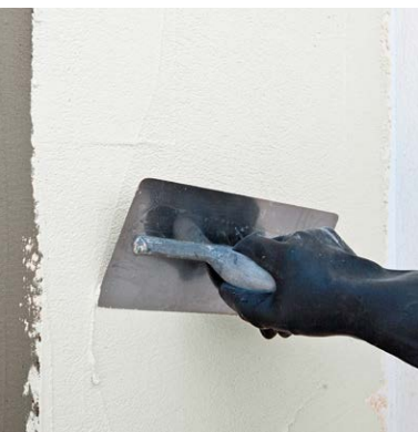
Applicazione della prima passata della tonachina con spatola di acciaio inox
