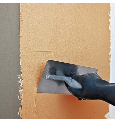
Applicazione di Taormina Sil con spatola metallica
