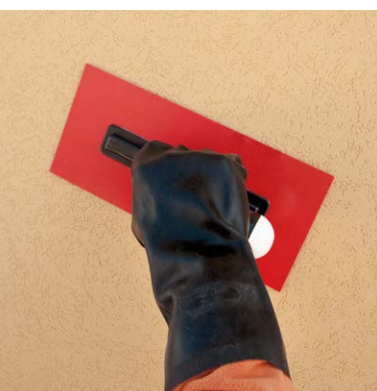
Finitura della superficie con fratazzo in plastica
