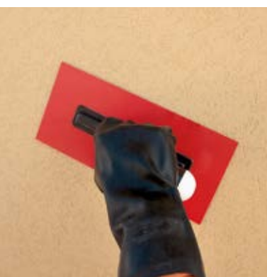
Finitura della superficie con fratazzo in plastica
