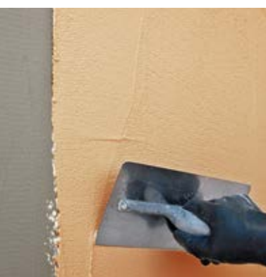
Applicazione di Taormina Plast con spatola metallica
