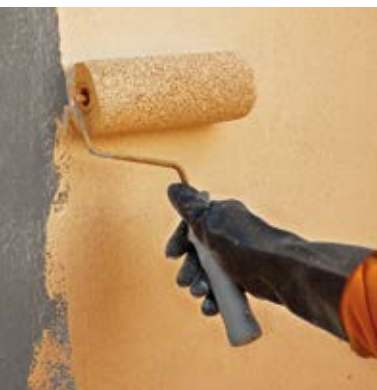
Applicazione a rullo o pennello di una passata di fissativo Anteplast per rivestimenti plastici
