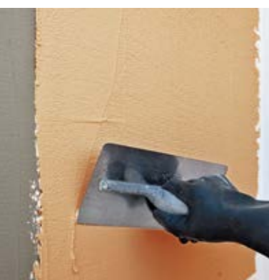
Applicazione di Cortina Silox con spatola metallica
