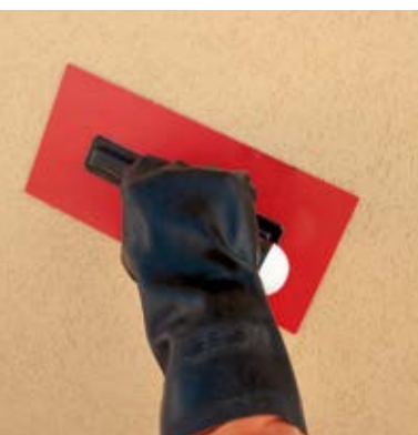
Finitura della superficie con fratazzo in plastica
