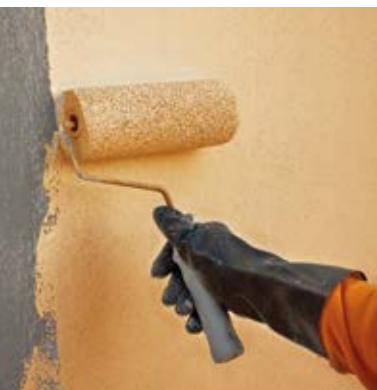
Applicazione a rullo o pennello di una passata di fissativo Anteplast per rivestimenti plastici
