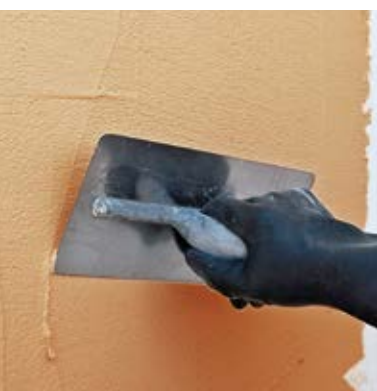
Applicazione di Taormina G Plast con spatola metallica
