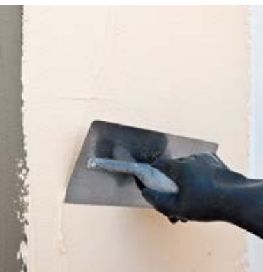
Applicazione della prima passata di Intonaco Monocalce con spatola di acciaio
