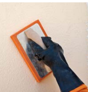
Lavorazione finale con fratazzo di plastica
