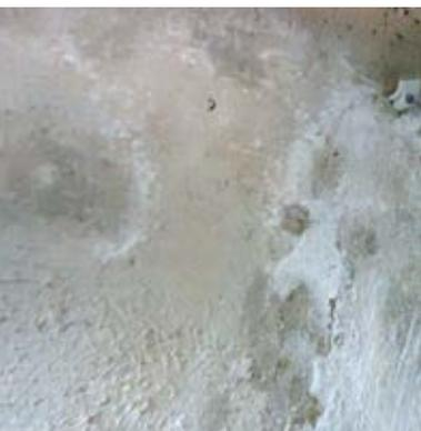
Muratura con umidità di risalita con la formazione di efflorescenza salina prima del risanamento
