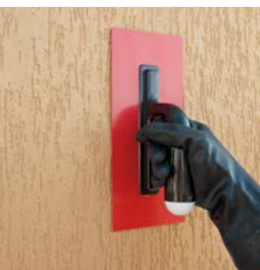
Finitura della superficie con fratazzo in plastica
