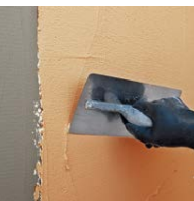
Applicazione di Graffiato Plast con spatola metallica
