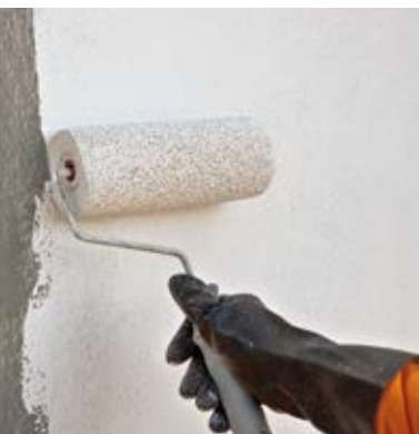
Applicazione di una passata di fissativo Anteplast per Taormina Plast
