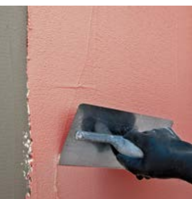
Applicazione di Acrilfinix-Sil con spatola metallica
