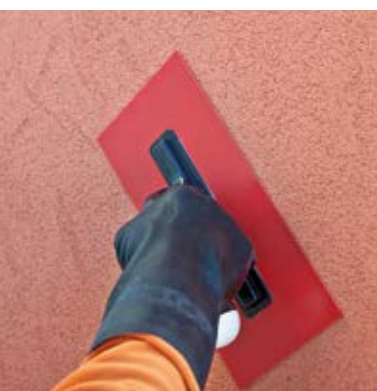
Finitura della superficie con fratazzo in plastica
