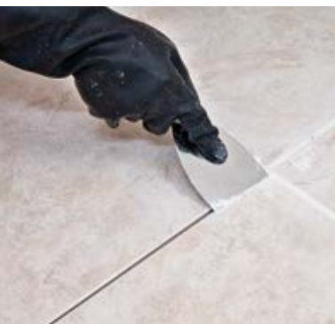
Stuccatura delle fughe
