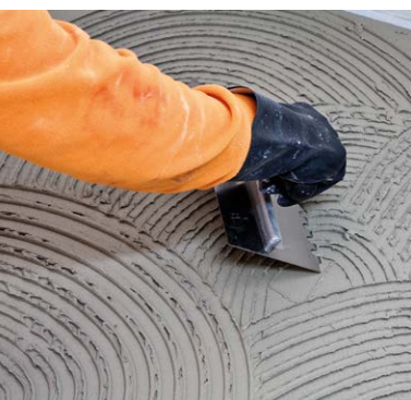
Applicazione di Flex Ultra C2TES2 con spatola metallica
