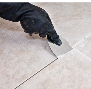
Stuccature delle fughe
