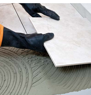
Posa delle piastrelle
